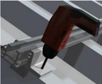
Abbildung 100: Klemme verbohren
